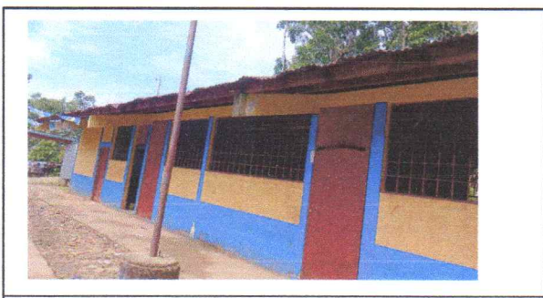
FOTO 5: Pintura en muros de exteriores e interiores
